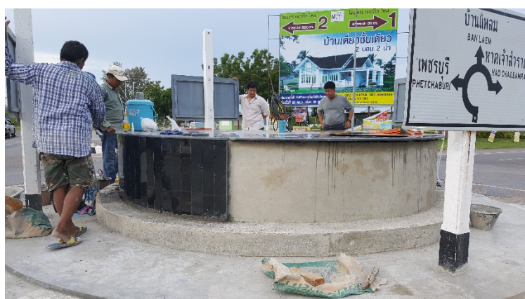
ภาพที่ 4-15 การก่อสร้างฐานวางผลงาน
