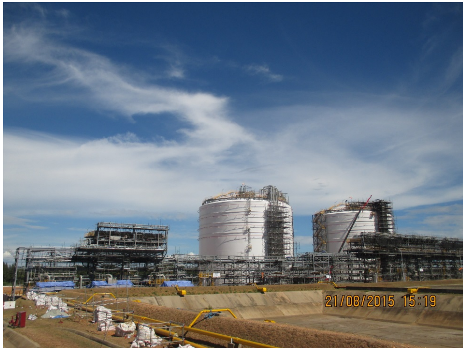
ภาพที่ 1-1 การก่อสร้างโรงงานผลิต LPG
