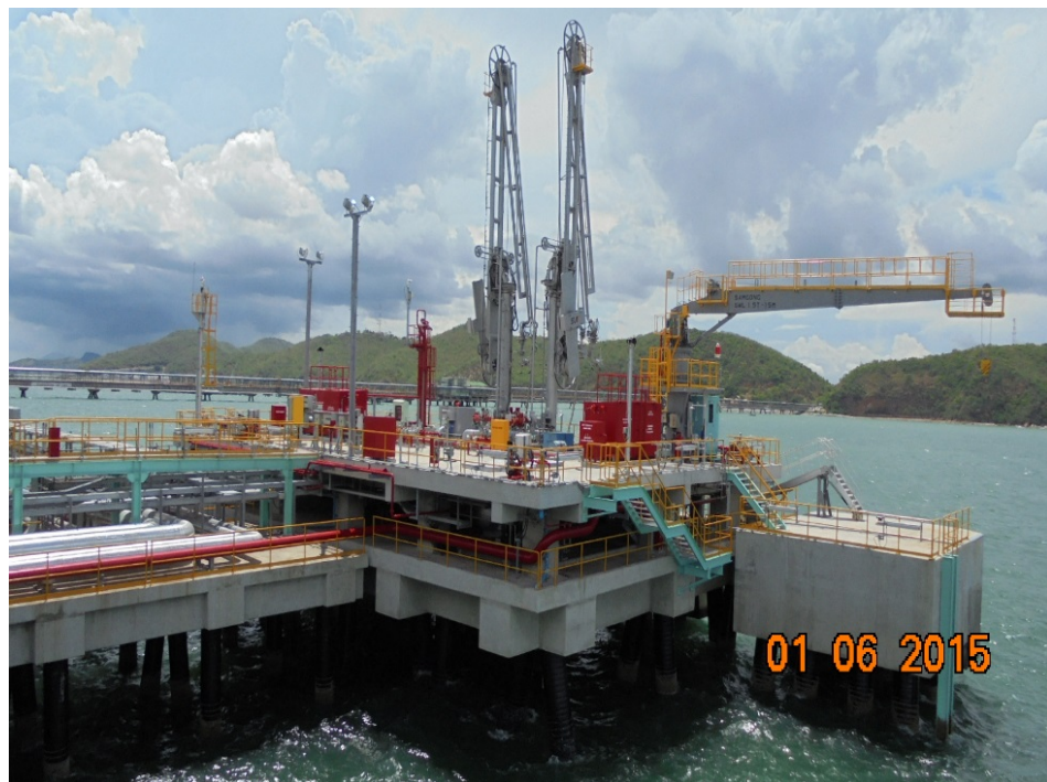
ภาพที่ 1-2 การก่อสร้างท่าเทียบเรือเพื่อขนถ่าย LPG
