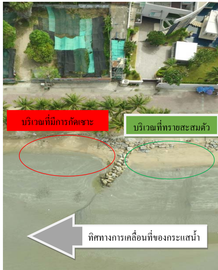
ภาพที่ 5-5 การสะสมของตะกอนทรายบริเวณรอดักทรายของพื้นที่หาดวอนนภา ช่วงมรสุมตะวันตกเฉียงใต้ถ่ายเมื่อวันที่ 23 สิงหาคม พ.ศ. 2558
