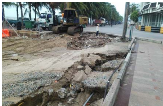
แนวฟุตบาทที่ถูกกัดเซาะบริเวณแหลมแท่น
