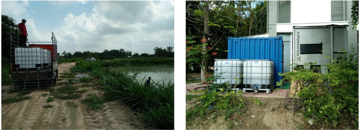
รูปที่ 3-1 นำน้ำเสียมจากบ่อบำบัดชั้นหลังของโรงงาน
