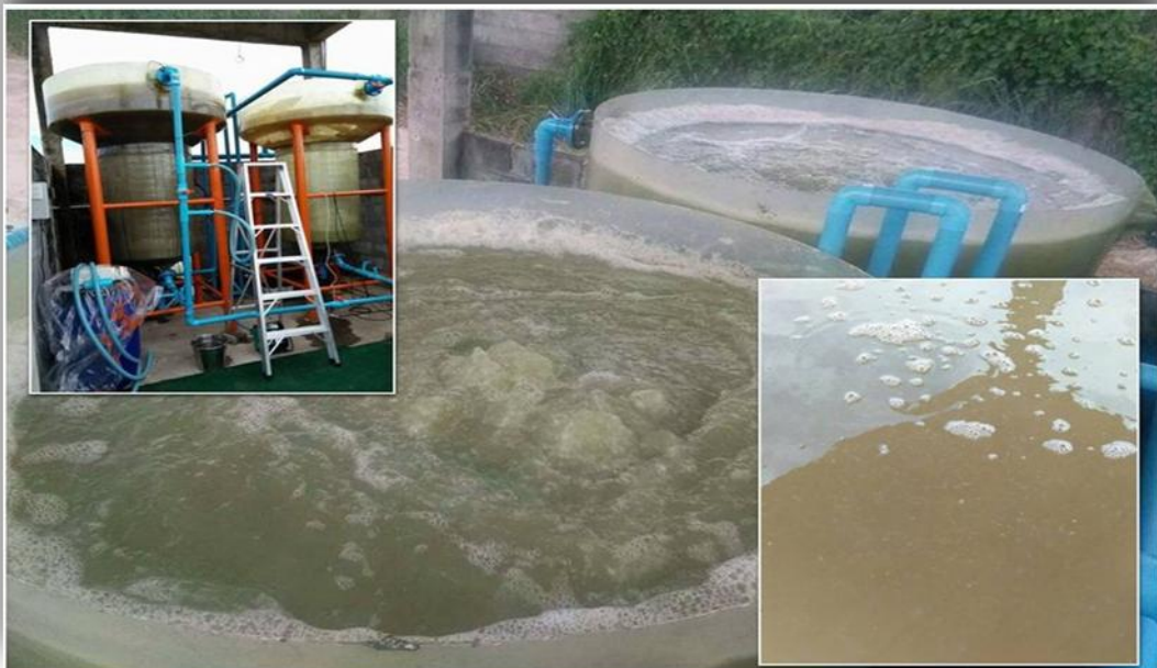
รูปที่ 5-5 แสดงการตกผลึกสตรูโวต์ระหว่างการเดินระบบ
