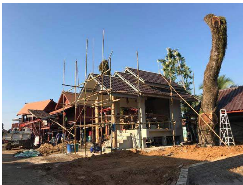
รูป ๕.๕ แสดงการก่อสร้างอาคารหลังใหม่ในเดือนธันวาคม พ.ศ.๒๕๖๐ ที่มา: เปลวเทียน เจษฎาชัยยุทธ์. ถ่ายเมื่อวันที่ ๑๕ ธันวาคม พ.ศ.๒๕๖๐.
