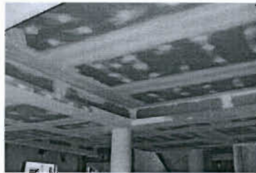
ภาพที่ 13 ตัวอย่างฝ้าเพดานฉาบเรียบ
