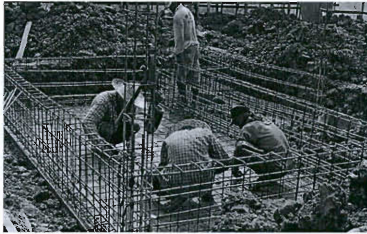
ภาพที่ 9 ตัวอย่างงานคอนกรีตเสริมเหล็ก
