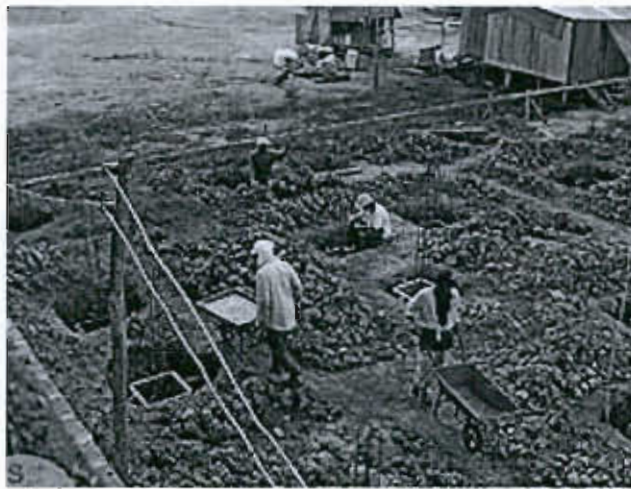
ภาพที่ 6 ตัวอย่างงานขุดหลุม
