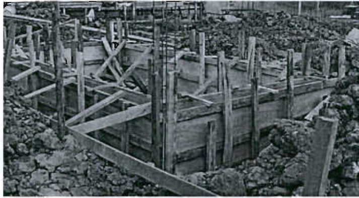
ภาพที่ 8 ตัวอย่างงานไม้แบบ
