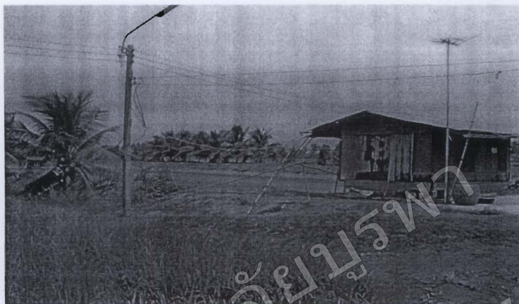
ภาพที่ 5-14 การสร้างที่พักชั่วคราวในพื้นที่นาและบ่อเลี้ยงปลาความสะดวกสบายเข้าถึงไฟฟ้า (ที่พักของชาวนา ตำบลบางแดน อำเภอบ้านสร้าง จังหวัดปราจีนบุรี วันที่ 26 มกราคม 2556: ถ่ายโดยชัยชนะ บุญเจริญ)
