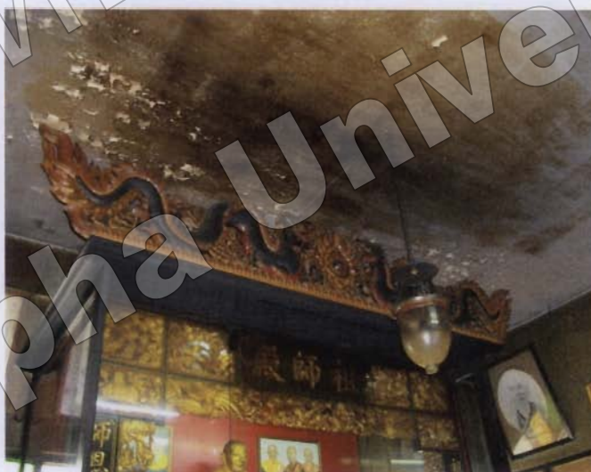
ภาพที่ 4-66 โครงสร้างของหลังคาวิหารบูรพาจารย์มีฝ้าเพดาน และเห็นร่องรอยของควันทูปบนฝ้าเพดาน
