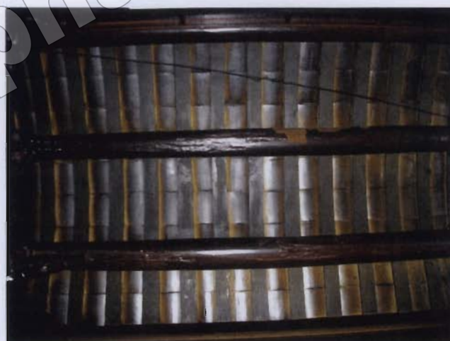
ภาพที่ 4-64 โครงสร้างของหลังคาวิหารหลักส่วนหน้า เป็นการปูไม้แบบโค้ง
