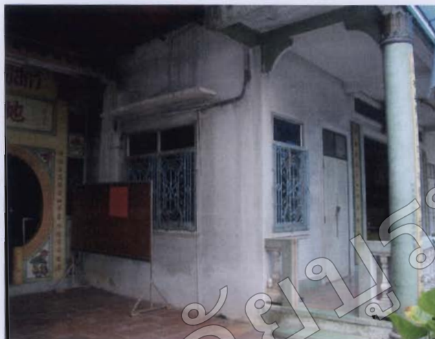
ภาพที่ 4-41 เสาคอนกรีตเสริมเหล็กกลม บัวหัวแบบบัววง
