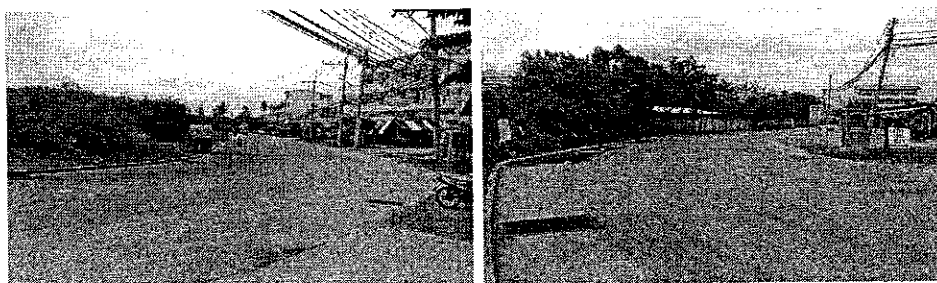
ค) ถนนเนตรดี ไม่มีเส้นแบ่งช่องจราจรที่ชัดเจน ง) มีช่องท่อระบายน้ำริมถนน ทำให้พื้นถนนไม่เสมอ
