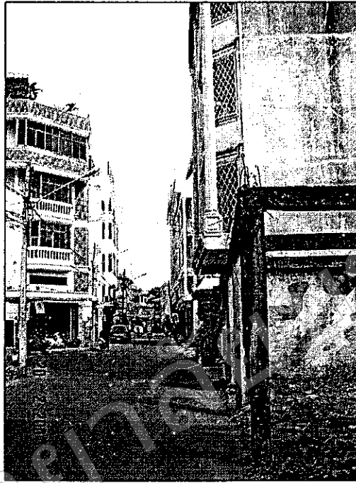
อาคารที่ปรากฏสภาพเสียหายเนื่องจากอัคคีภัย เมื่อปี พ.ศ. 2533 และอาคารที่ก่อสร้างขึ้นใหม่บนพื้นที่เดิม
