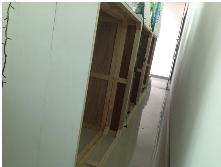
ภาพที่ 4-75 ภาพการเตรียมการติดตั้งผลงาน 3
