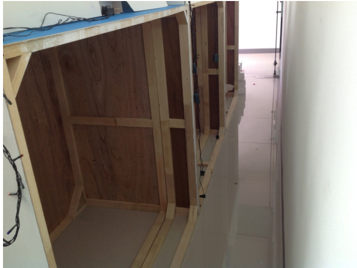
ภาพที่ 4-74 ภาพการเตรียมการติดตั้งผลงาน 2
