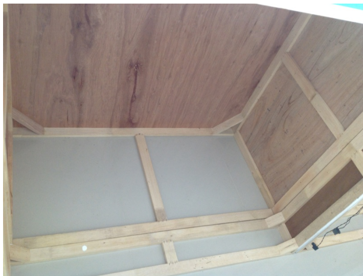
ภาพที่ 4-73 ภาพการเตรียมการติดตั้งผลงาน 1
