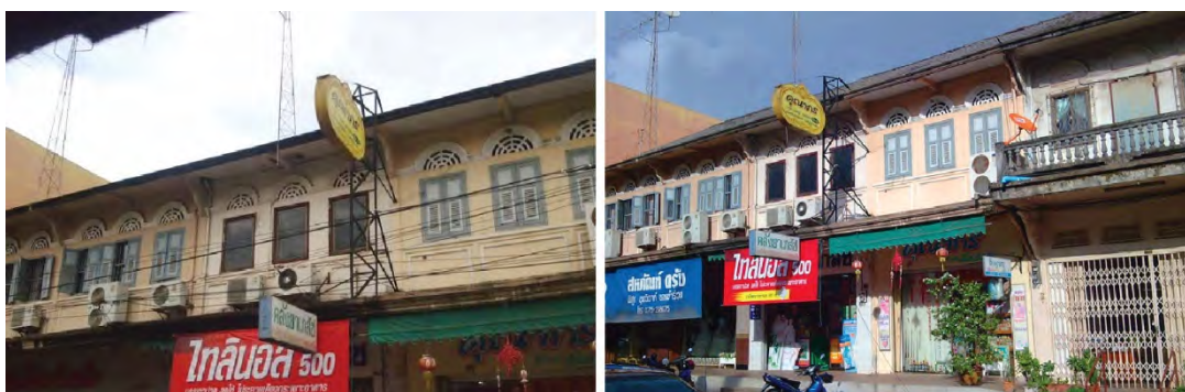
ภาพที่ 2-9 ภาพเปรียบเทียบ ก่อนและหลังการนำสายไฟฟ้าลงใต้ดิน ( www.trachang.co.th/ )
