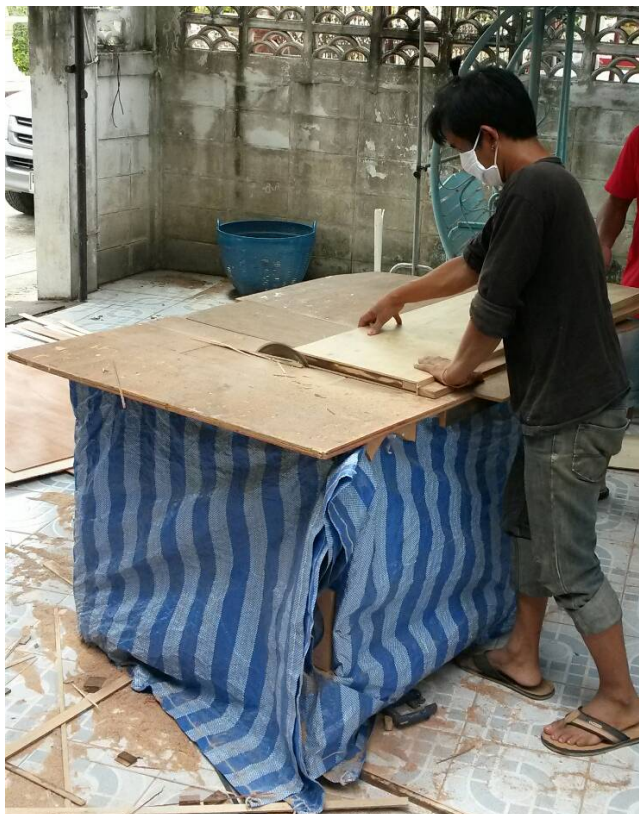
ภาพที่ 4-23 วัดขนาดและตัดไม้
