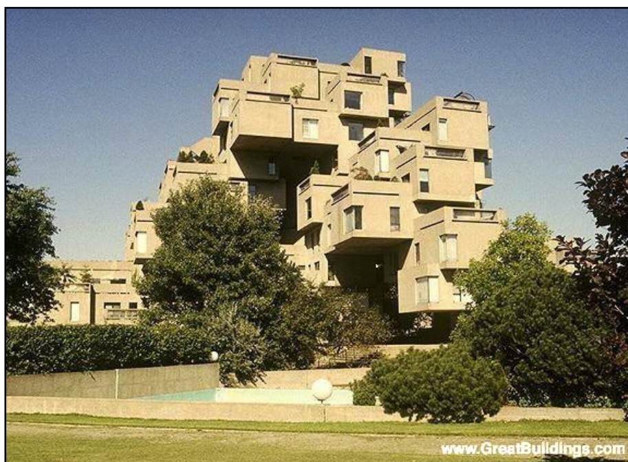
ภาพที่ 2-2 อาคารที่สร้างด้วยระบบโมดูลาร์ (www.schousefactory.com)
