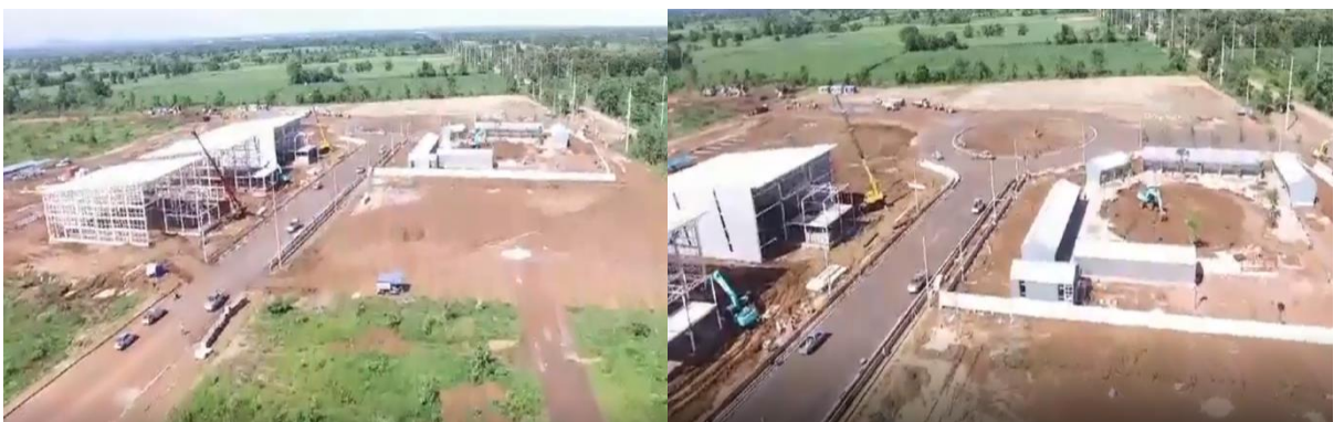
ภาพที่ 5-18 การก่อสร้างโครงการก่อสร้างนิคมอุตสาหกรรมสระแก้ว ระยะที่ 1 (สำนักงานจังหวัดสระแก้ว, 2559)
