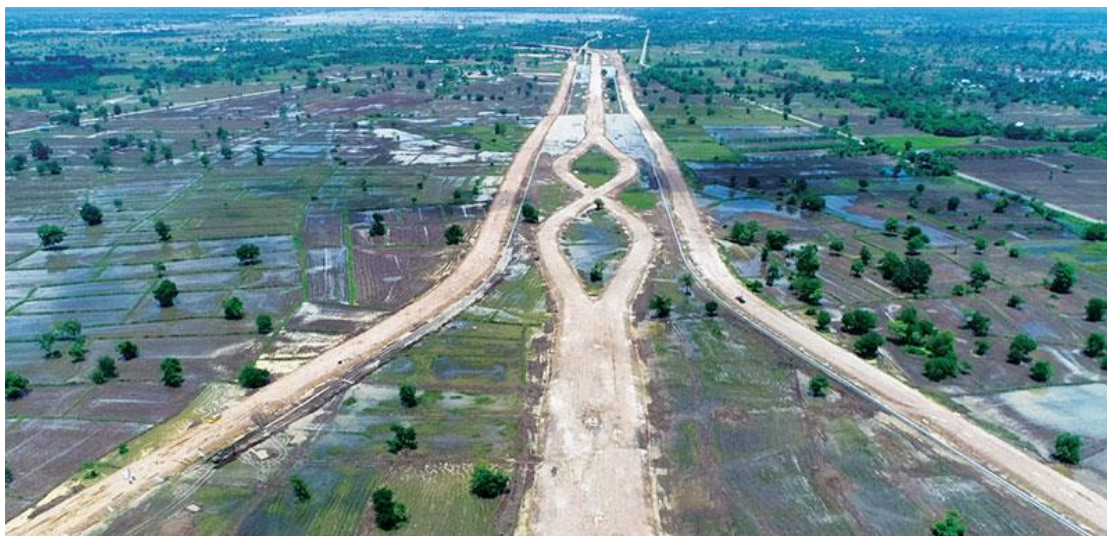
ภาพที่ 5-32 โครงการก่อสร้างทางหลวงเชื่อมโยง จุดผ่านแดนสายอรัญประเทศ ชายแดนไทย – กัมพูชา
