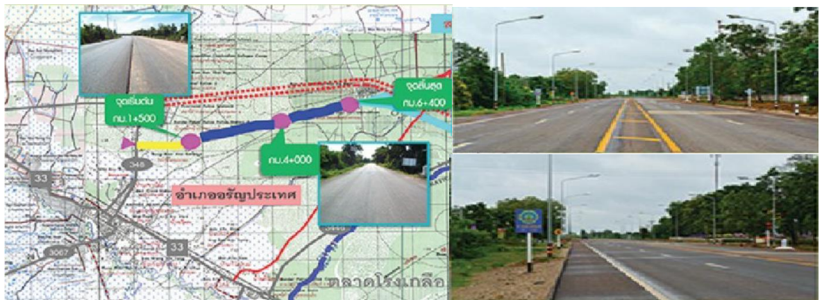
ภาพที่ 5-29 โครงการก่อสร้างถนน สาย สก 3085 แยกทางหลวงหมายเลข 348 – บ้านนางาม (สำนักงานจังหวัดสระแก้ว, 2559, หน้า 15)
