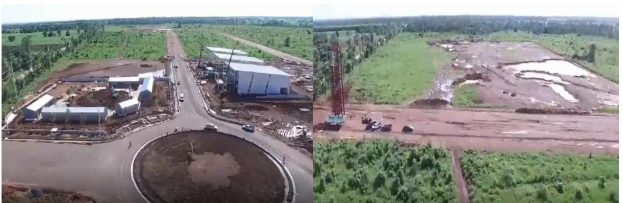
ภาพที่ 5-17 การก่อสร้างโครงการก่อสร้างนิคมอุตสาหกรรมสระแก้ว ระยะที่ 1 (สำนักงานจังหวัดสระแก้ว, 2559)
