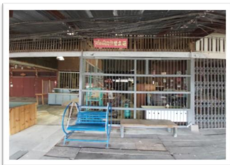
ภาพที่ 5-16 ตัวอาคารไม้สองชั้น อาคารรุ่งเรืองชัยฤๅกิจ
