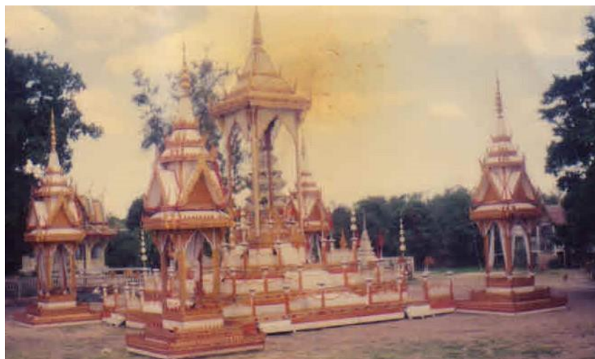
ภาพที่ 5-46 เมรุลอยอยุธยาทรงบุษบกผสมจตุรมุขของจรัญเมรุลอย (นายหิรัญ กิจเพ็ชร) แบบ 5 ยอด 4 ชั้น เรือนกลางเป็นทรงบุษบกแผงสาน เรือนบริวารแบบจตุรมุขงานไม้อัด (วินัย กิจสุทธิ, 2534)
