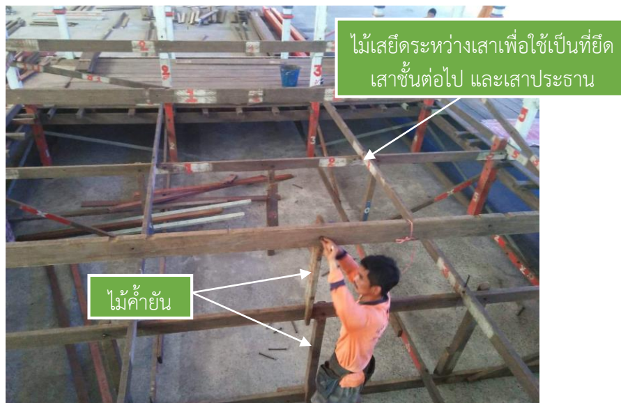
ภาพที่ 5-96 การใส่ไม้ค้ำยันเพื่อเสริมความแข็งแรงให้แต่ละชั้น
