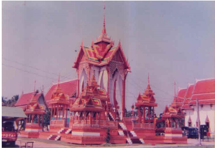
ภาพที่ 5-8 เมรุลอยยอยุธยาทรงมุข แบบ 9 ยอด 4 ชั้น เรือนกลางเป็นพลับพลา मुखเสา 8 ของ เมรุลอยครุอาบ (นายอาบ สุขชาสุณี) (หลังจากปี พ.ศ. 2520) (วินัย กิจสุทธิ, 2534)
