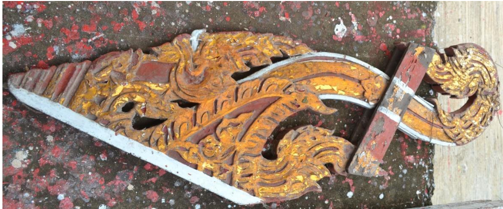
ภาพที่ 5-20 ลักษณะลายคันทวยเป็นลายชุด ทาสี ปิดกระดาดาชทอง ของจรัญเมรุลอย (นายหิรัญ กิจเพชร) ปัจจุบันใช้ลายแปะแทนลายชุด
