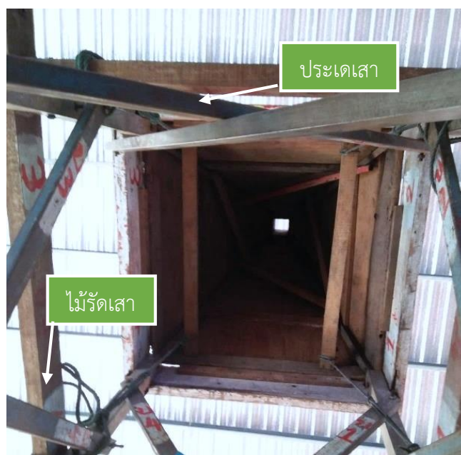
ภาพที่ 5-100 โครงสร้างภายในยอด
