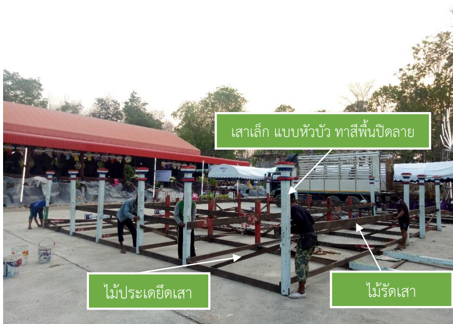
ภาพที่ 5-90 การตั้งเสาบริวาร (เสาเล็ก) ของเมรุลอยอยุธยา
