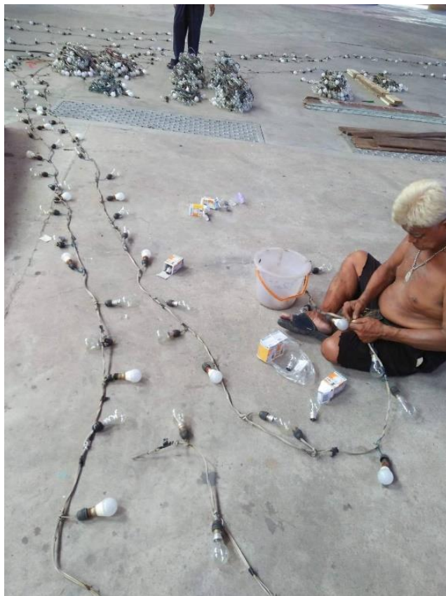
ภาพที่ 5-102 การตรวจเช็คสภาพหลอดไฟและสายไฟก่อนนำไปประดับของเมรุลอยอยุธยา
