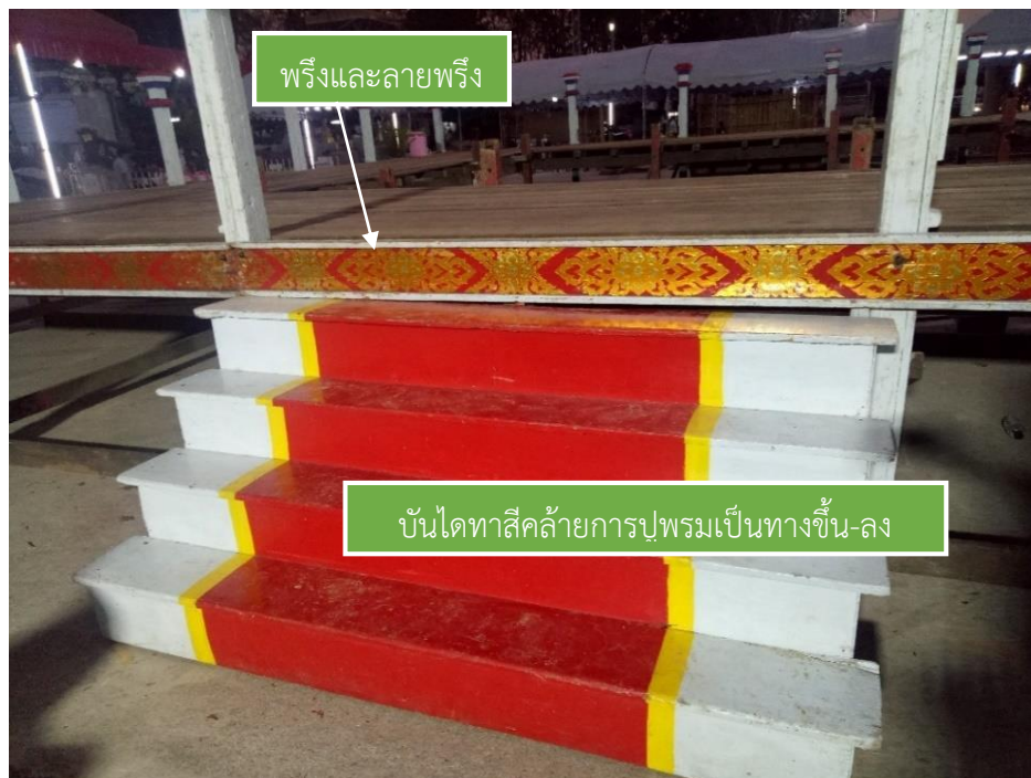
ภาพที่ 5-94 การติดบันไดเมรุลอยอยุธยาเริ่มจากชั้นล่างสุดของฐานก่อน
