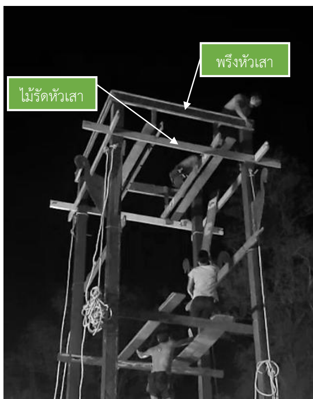
ภาพที่ 5-98 การขึ้นใส่องค์ประกอบส่วนยอด
