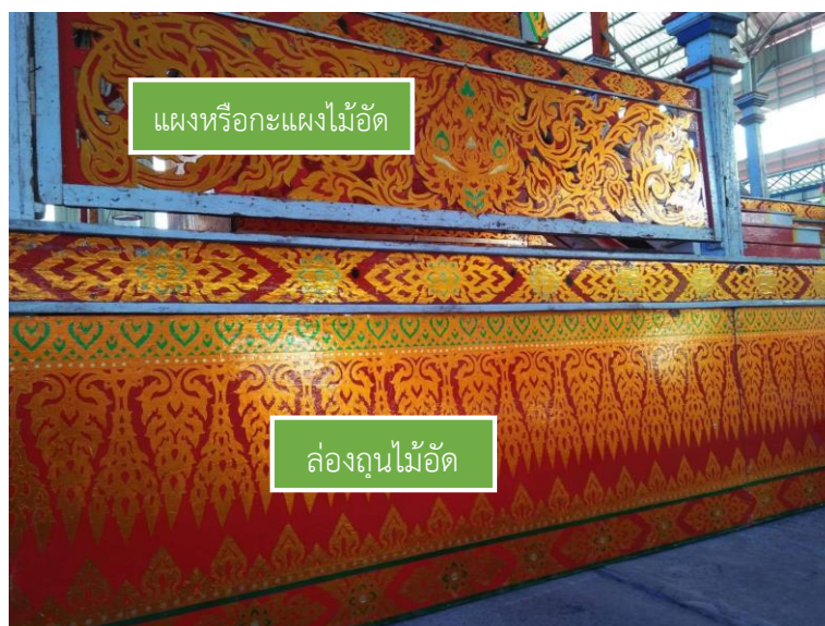
ภาพที่ 5-101 การใส่องค์ประกอบตกแต่งส่วนฐานของเมรุลอยอยุธยา
