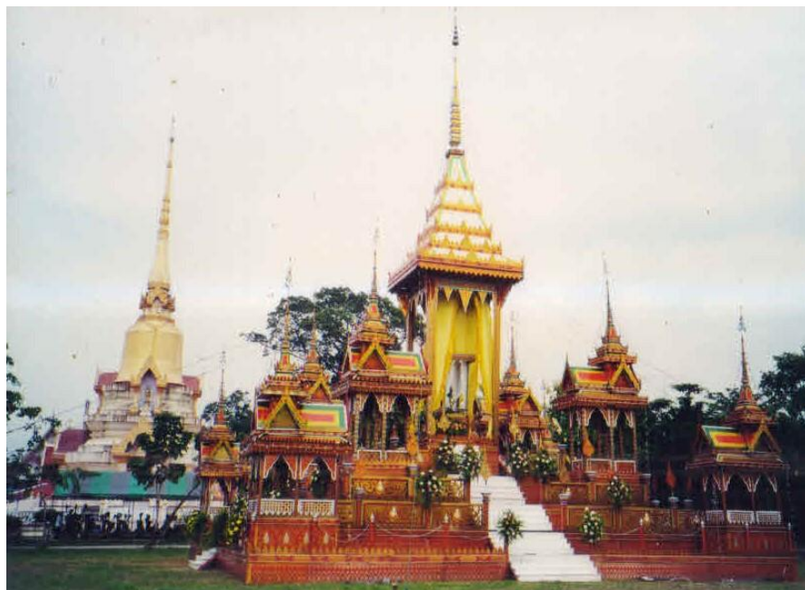
ภาพที่ 5-10 เมรุลอยอยุธยาแบบบุษบกผสมมุขที่ใช้งานไม้อัดทำส่วนตกแต่งทั้งหมด แบบ 9 ยอด 5 ชั้น ของเมรุลอยครูอาบ (นายอาบ สุขชาสุณี) (วินัย กิจสุทธิ, มปป.)
