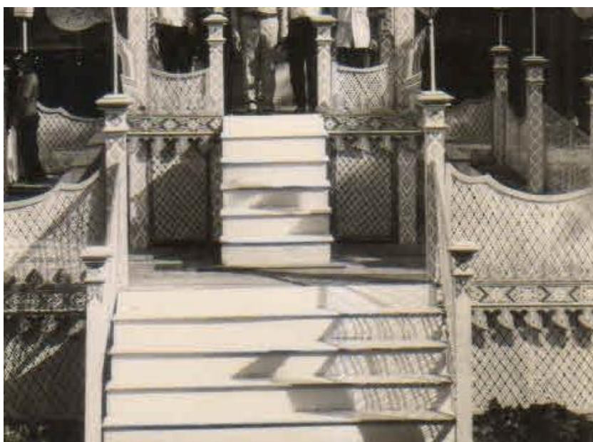
ภาพที่ 5-58 การใช้แผงสานในส่วนของร่องถุนและแผงระหว่างเสาของเมรุลอยอยุธยา (อาบ สุขษาสุณี, 2511)
