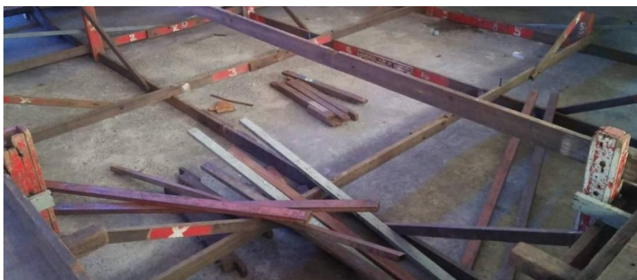
ภาพที่ 5-57 การใช้การสลักสับหว่างขององค์ประกอบแต่ละชิ้นส่วนเพื่อให้เกิดความแน่นอน ซึ่งในปัจจุบันมีการใช้น็อต ตะปู ช่วยยึดให้มีความแข็งแรงมากยิ่งขึ้น
