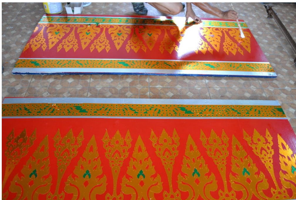
ภาพที่ 5-47 การใช้ไม้อัดตัด สาที่ ปิดลาย ลงเงา กับส่วนประกอบตกแต่งในเมรุลอยอยุธยา
