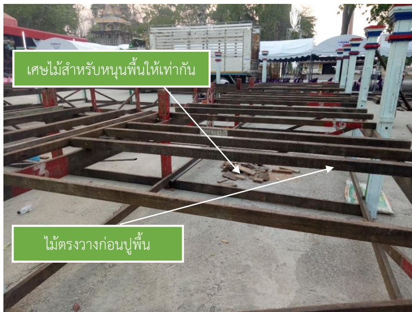
ภาพที่ 5-92 การวางไม้ตรงเสริมก่อนการปูไม้กระดานบนเมรุลอยอยุธยา
