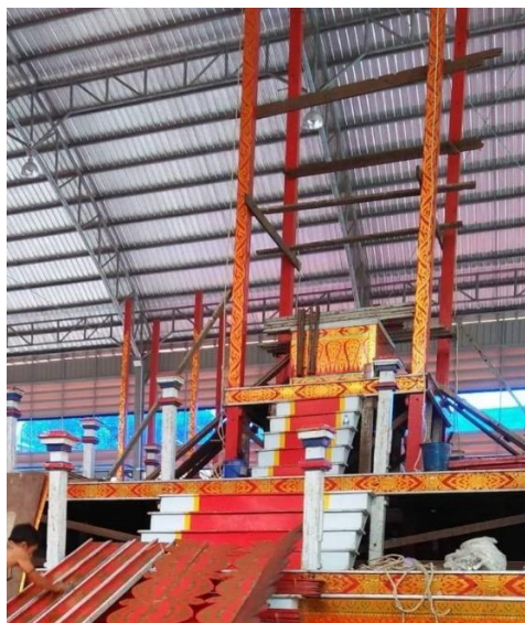
ภาพที่ 5-97 หลังจากขึ้นเสาประธานแล้วเตรียมเครื่องยอด (อุปกรณ์ของส่วยยอด) ก่อนจะขึ้นไป ประกอบบนยอด โดยจะใช้คนอย่างน้อย 4 คน ประจำเสาแต่ละต้นการประกอบส่วนยอด
