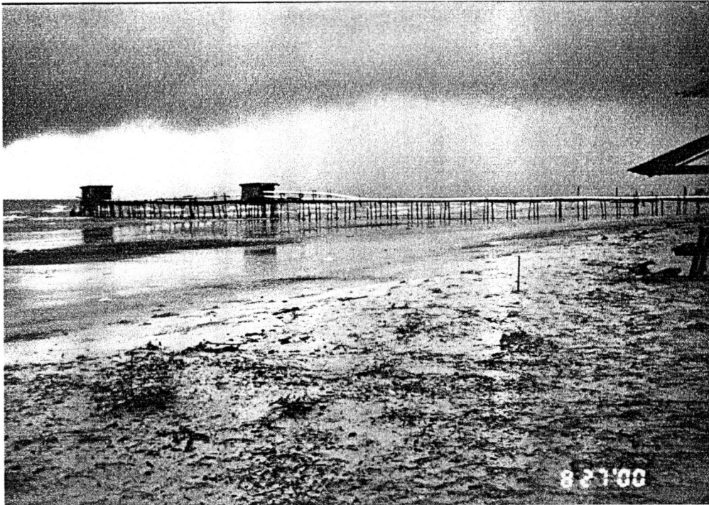
รูปที่ 45 หาดชาญชล หาดทรายกว้างปานกลาง มีการก่อสร้างที่พักตากอากาศ และมีการสร้างสะพานยื่นลงไปทะเล
