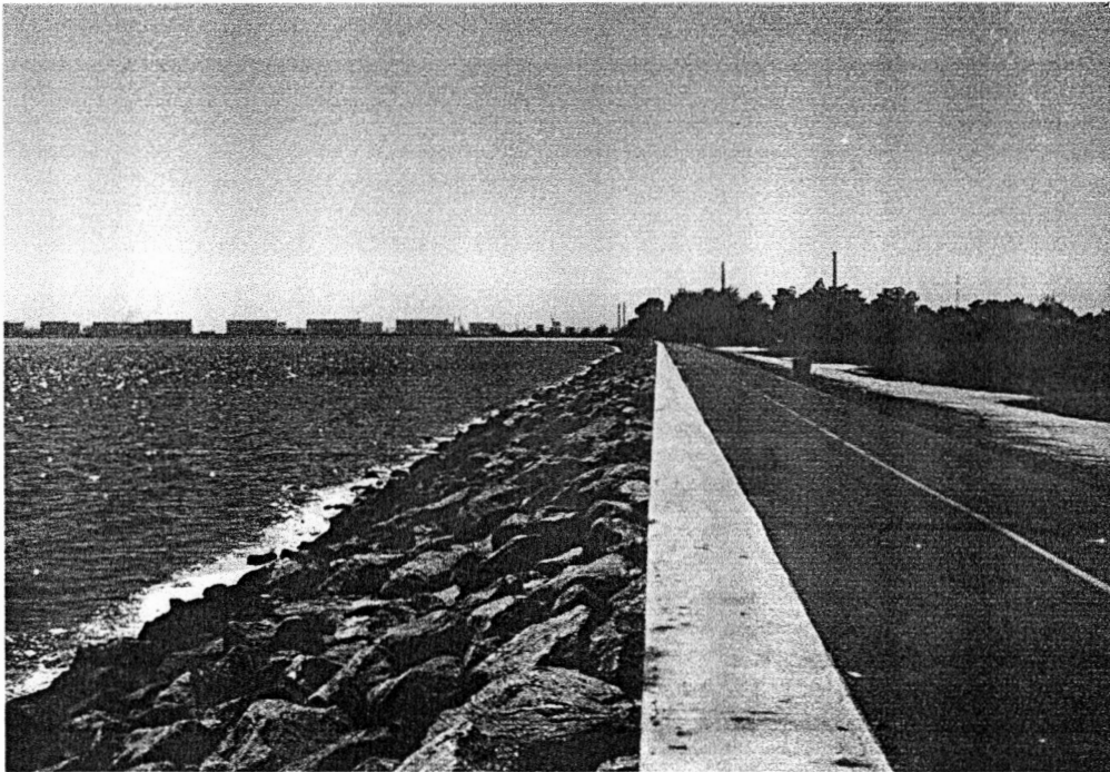
รูปที่ 40 หาดทรายทอง ปัจจุบันไม่หลงเหลือให้เห็นลักษณะของหาดทราย เนื่องจากชายฝั่งถูกกัดเซาะ มีการก่อสร้างถนนและนำหินมาถมบริเวณชายฝั่ง
