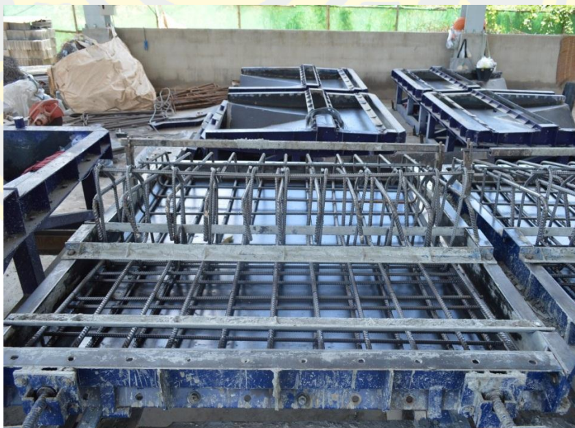
ภาพที่ 4 แผ่นกันตก (Parapet) รอเทปูน ที่มา: โครงการก่อสร้างแห่งหนึ่งในจังหวัดนครราชสีมา หมายเหตุ ได้รับอนุญาตจากโครงการก่อสร้างให้นำเสนอภาพการปฏิบัติงานโดยผู้จัดการโครงการ
