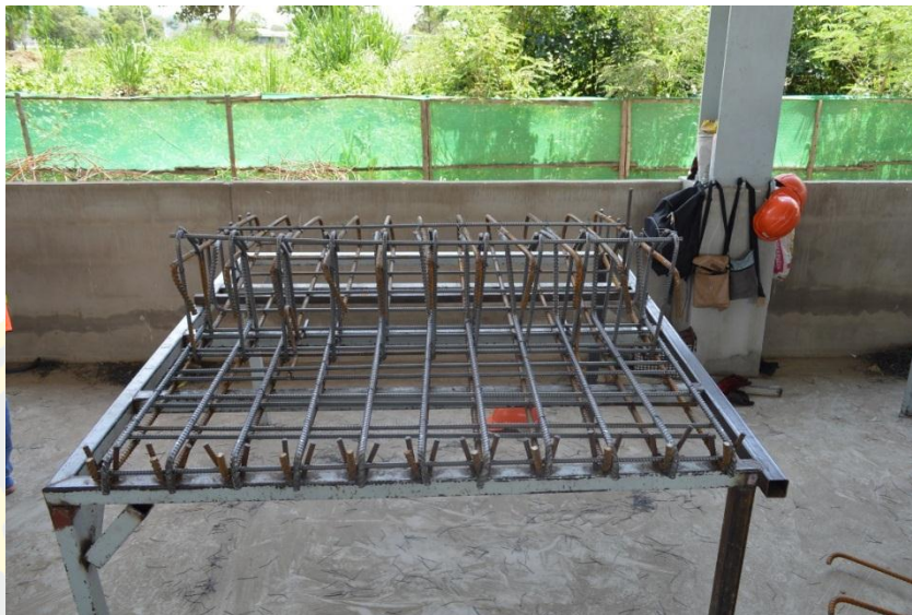
ภาพที่ 3 แผ่นกันตก (Parapet) หลังจากผูกมัดเสร็จ ที่มา: โครงการก่อสร้างแห่งหนึ่งในจังหวัดนครราชสีมา หมายเหตุ ได้รับอนุญาตจากโครงการก่อสร้างให้นำเสนอภาพการปฏิบัติงานโดยผู้จัดการโครงการ
