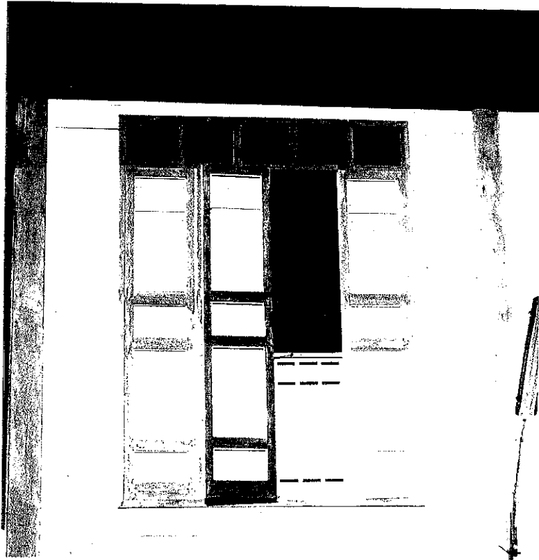
ภาพที่ 60 หน้าต่างแบบบานขาวมีลูกกรงกันตกด้านใน
