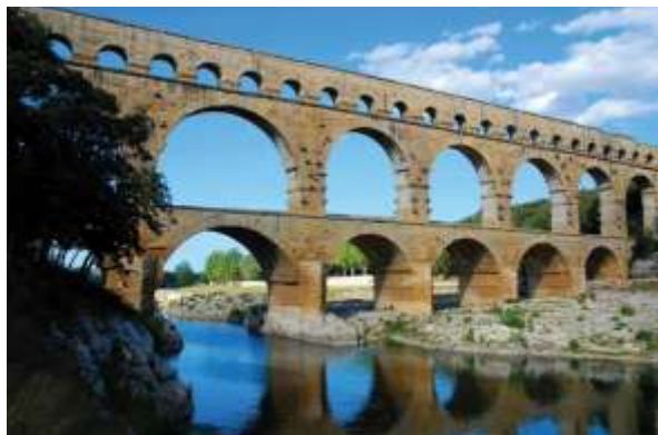
ภาพที่ 21 PontduGard สะพานท่อระบายน้ำวิศวกรรมโรมันโบราณสร้างเมื่อประมาณ 19 ปีก่อนคริสตกาล (global.britannica.com)
