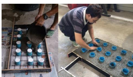
ภาพที่ 3-27 การเทคอนกรีตทำชุดแปลงทดลองคอนกรีต
