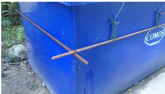
ภาพที่ 3-56 เหล็กเส้น RB 16 มิลลิเมตร สำหรับรัดรอบกระบะพลาสติกป้องกันการปริแตก
