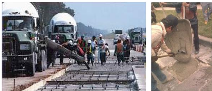
ภาพที่ 2-3 การใช้ Pyrament ในประเทศสหรัฐ เป็นวัสดุสำหรับซ่อมแซม Pavement (Davidovits, 2002)
