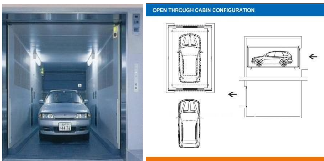
ภาพที่ 2-4 ลักษณะของลิฟต์บรรทุกรถยนต์ (บริษัท สยามฮิตาชิ เอลเลเวเตอร์ จำกัด, 2558)
