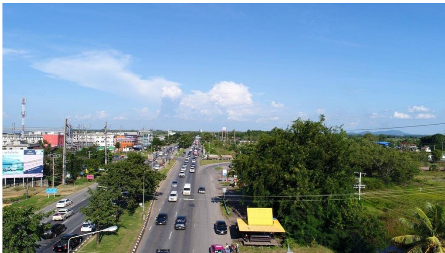
ภาพที่ 3-7 ภาพมุมสูงบริเวณทางแยกพื้นที่ศึกษา (แยกบางคล้า) จังหวัดฉะเชิงเทรา (ทิศทาง อำเภอพนมสารคาม-จังหวัดฉะเชิงเทรา)
