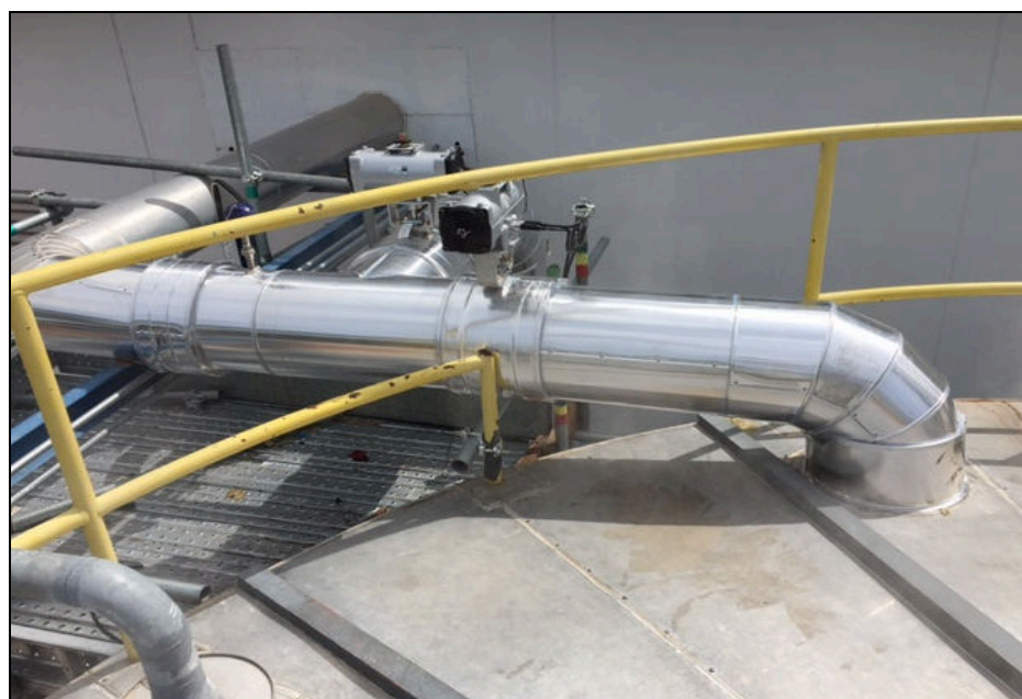
ภาพที่ 4-4 ตำแหน่งของวาล์วและการหุ้มฉนวนท่อน้ำร้อน
