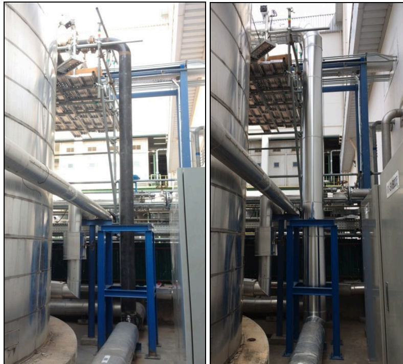
ภาพที่ 4-5 ท่อระบายน้ำลงบ่อน้ำบำบัดก่อน-หลังการหุ้มฉนวน
