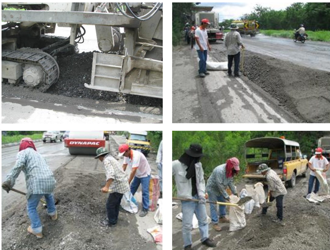
ภาพที่ 3-6 การเก็บตัวอย่างวัสดุโดยวิธีใช้รถขุดผสม
