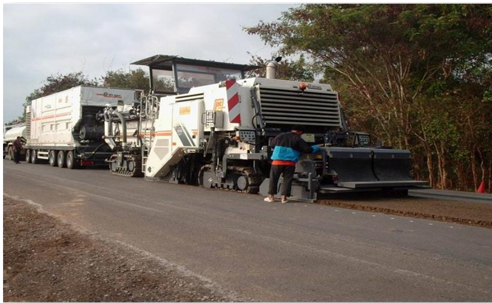
ภาพที่ 1-4 การทำงาน Pavement in-place recycling
