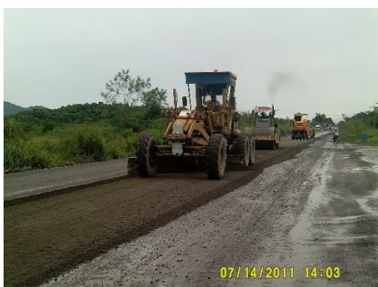
ภาพที่ 2-5 กระบวนการบดทับและปรับแต่งระดับ
