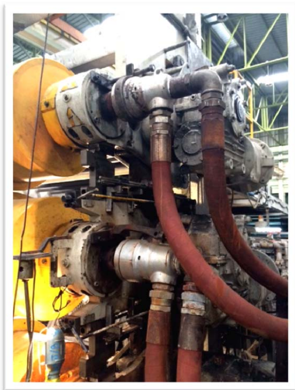
ภาพที่ 4-5 นำชุด Rotary joint ไปประกอบกับเครื่อง Extruder
