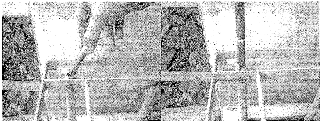
(ค) หย่อนเหล็กลงในคอนกรีต (ง) ตรวจสอบว่าเหล็กที่ฝังอยู่ในตำแหน่งที่ต้องการ
