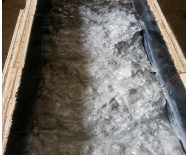
รูปที่ 4.24 ติดตั้งแบบหล่อคอนกรีตและท่อน้ำยาเชื่อมประสาน
