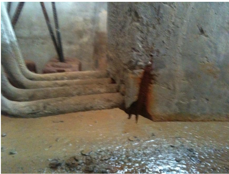
รูปที่ 4.6 คาน B30 ที่ปลายคานใต้เหล็กเสริมล่างเนื้อคอนกรีตมีการหลุดออก คานอยู่ในสถานะที่ 2
