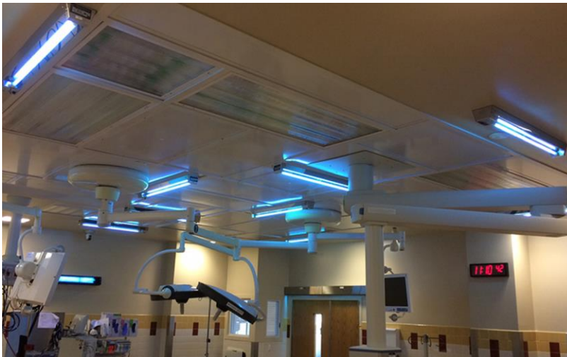
รูปที่ 4.1 การฆ่าเชื้อโรคในโรงพยาบาลด้วยการฉายรังสี UV-C
