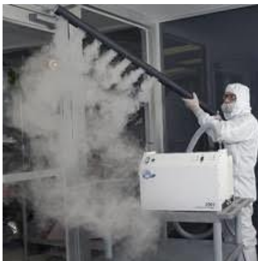
รูปที่ 4.2 การฆ่าเชื้อโรคห้องด้วยการ fume ด้วยฟอร์มาลดีไฮด์
