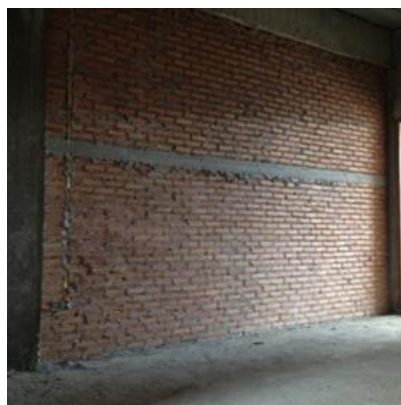
รูปที่ 2.3-2 อาคารที่ใช้อิฐมอดุตันในการก่อสร้างผนัง (ลีลาทวิวัฒน์ และคณะ 2561)
