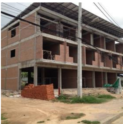
รูปที่ 2.3-2 อาคารที่ใช้อิฐมอดุตันในการก่อสร้างผนัง (ลีลาทวิวัฒน์ และคณะ 2561)
