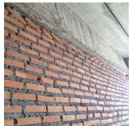
รูปที่ 2.3-2 อาคารที่ใช้อิฐมอดุตันในการก่อสร้างผนัง (ลีลาทวิวัฒน์ และคณะ 2561)
