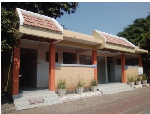
ภาพที่ 4-21 ห้องน้ำบริเวณติดประตูรั้วด้านหน้าวัดราษฎร์ศรัทธาทาลังปรับปรุงเสร็จสมบูรณ์
