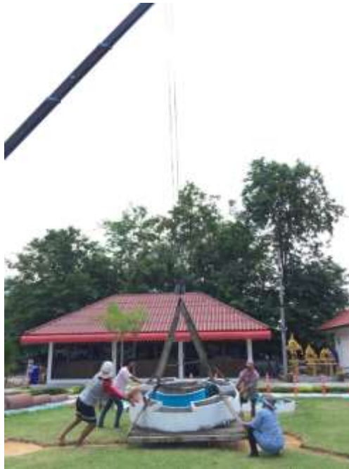
ภาพที่ 4-122 สร้างส่วนฐานผลงาน โครงสร้างผลงานที่เป็นปูน
