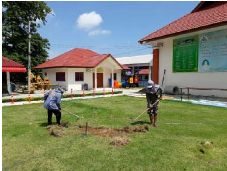
ภาพที่ 4-118 ขุดล่องเพื่อการติดตั้งส่วนฐาน
