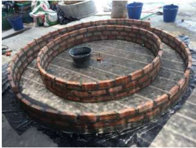
ภาพที่ 4-112 ก่ออิฐทำฐานผลงาน
