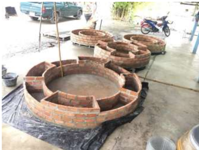
ภาพที่ 4-113 ก่ออิฐทำฐานผลงาน
