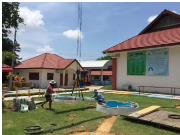
ภาพที่ 4-123 สร้างส่วนฐานผลงาน โครงสร้างผลงานที่เป็นปูน
