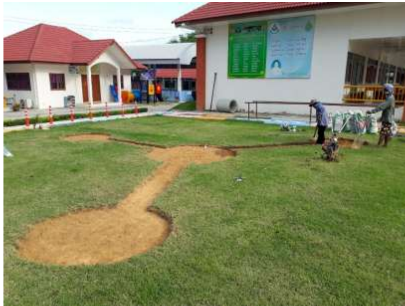
ภาพที่ 4-120 ขุดล่องเพื่อการติดตั้งส่วนฐาน
