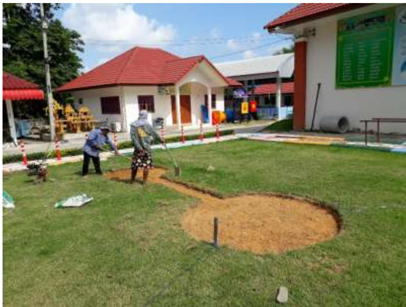
ภาพที่ 4-119 ขุดล่องเพื่อการติดตั้งส่วนฐาน
