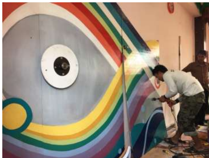
ภาพที่ 4-181 ติดตั้งผลงานประกอบ โครงสร้าง
