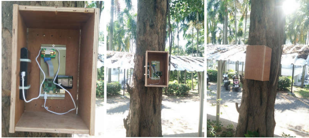
ภาพที่ 4.13 การติดตั้งการพัฒนาเครื่องเก็บข้อมูลระยะไกลเพื่อเฝ้าระวังการปลดปล่อย ก๊าซคาร์บอนไดออกไซด์ในพื้นที่
