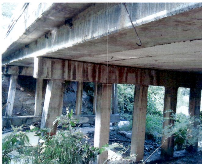
รูปที่ 3.9 ลักษณะโครงสร้างของสะพานที่ทำการทดสอบ
