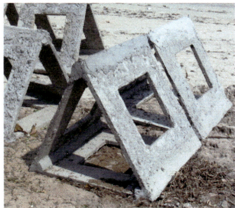
ภาพที่ 1 ท่อคอนกรีตทรงกระบอกเรียงซ้อนกัน ภาพที่ 2 คอนกรีตทรงสามเหลี่ยมหล่อโปร่ง เป็นทรงสามเหลี่ยม
