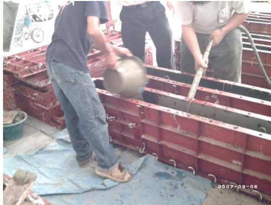
รูปที่ 3.37 การจี้แบบหล่อคานตัวอย่างทดลองด้วยเครื่องจี้เขย่าคอนกรีต
