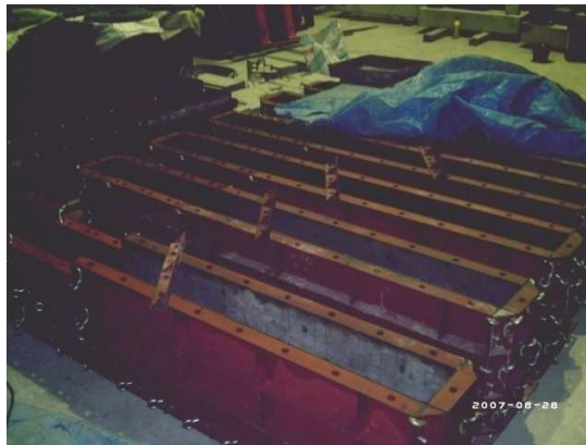
รูปที่ 3.2 แบบหล่อนคานคอนกรีตเสริมเหล็ก
