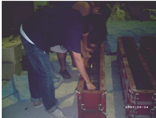
รูปที่ 3.29 การนำคานตัวอย่างที่ประกอบเสร็จใส่ลงในแบบหล่อคานทดสอบ
