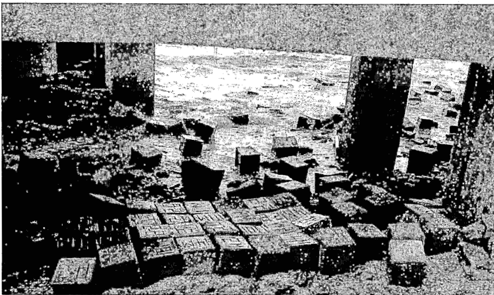
รูปที่ 3.9 ตัวอย่างคอนกรีตที่แช่บริเวณชายฝั่งทะเล จ.ชลบุรี
