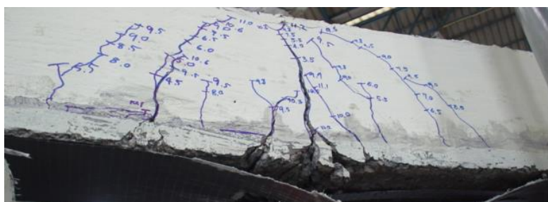
รูปที่ 5.31 ลักษณะรอยร้าวของคานคอนกรีตเสริมเหล็ก B02
