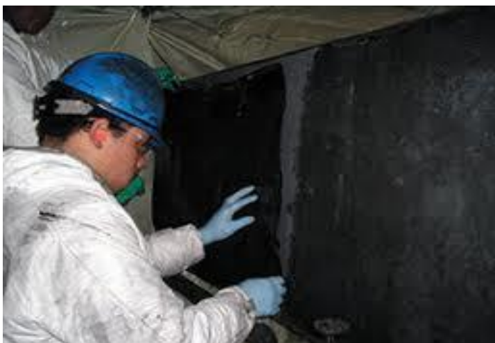
รูปที่ 1 การใช้แผ่นไฟเบอร์ในการเสริมกำลังคานและเสาคอนกรีตเสริมเหล็ก
