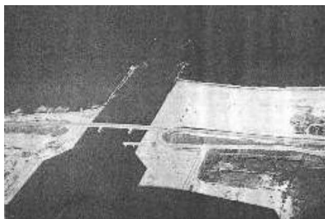
รูปที่ 2.9 กำแพงกันคลื่นแบบ Jetty
