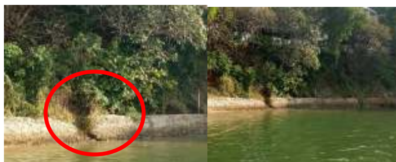
รูปที่ 3.3 แนวกำแพงที่น้ำมีการท่วมถึง เกิดการแยก พังทลาย เกิดสภาวะที่ดินดันกำแพง
