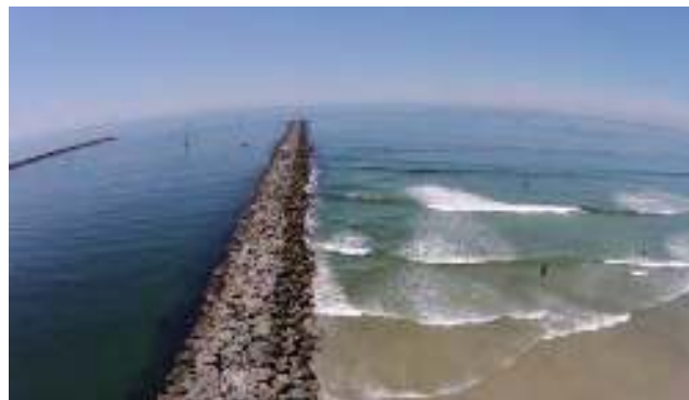
รูปที่ 2.8 กำแพงกันคลื่นแบบ Jetty
