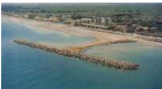
รูปที่ 2.11 เขื่อนกันคลื่นนอกชายฝั่ง (Offshore Breakwater)
