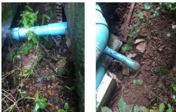
ภาพที่ ๗ ลักษณะท่อส่งน้ำประปารั่วระหว่างการส่งน้ำขึ้นถึงพักบนหอพัก (ที่มา : ภาพถ่ายโดยผู้เขียน )
