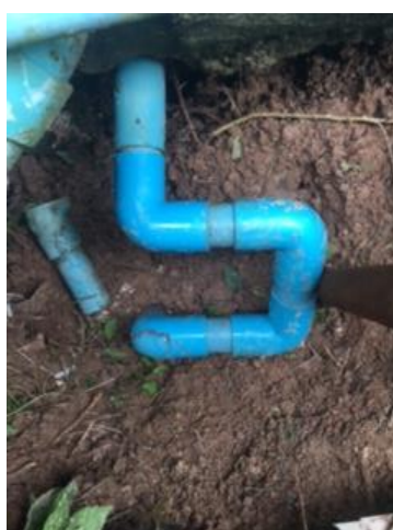
ภาพที่ ๙ ลักษณะการต่อท่อกับงานซ่อมแซมระบบประปา (ที่มา : ภาพถ่ายโดยผู้เขียน)
