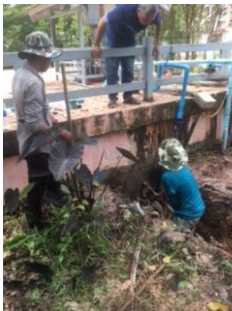
ภาพที่ ๑๓ การทำงานซ่อมแซมรอยรั่วของท่อประปา (ที่มา : ภาพถ่ายโดยผู้เขียน)
