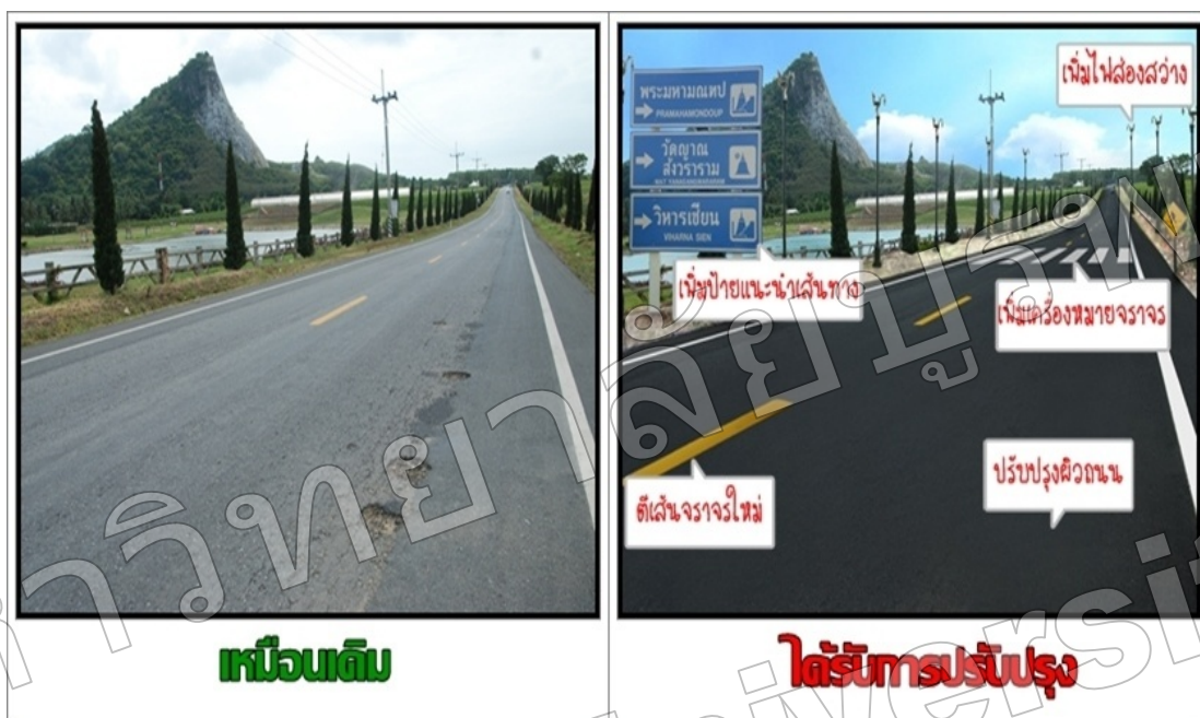
รูปที่ 4.1 สภาพพื้นผิวจราจรและองค์ประกอบของถนน
