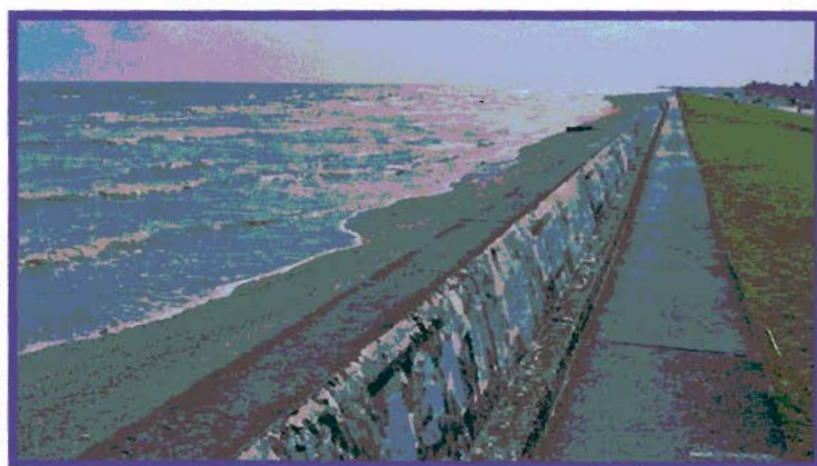
รูปที่ 2.2 ภาพแสดงกำแพงกันคลื่นป้องกันการกัดเซาะชายฝั่งทะเล ที่มาของภาพ : http://www.traveladventures.org
