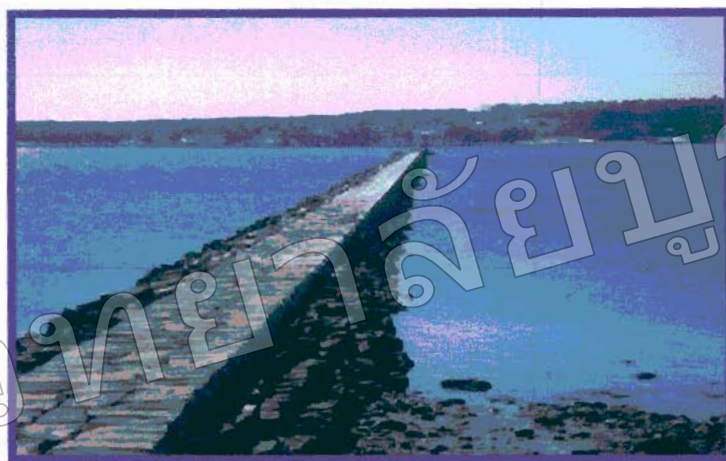
รูปที่ 2.1 ภาพแสดงเขื่อนกันคลื่นป้องกันการกัดเซาะชายฝั่งทะเล ที่มาของภาพ : http://photos.igougo.com
