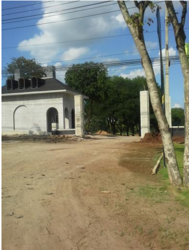
ภาพที่ ค-9 พื้นที่กำลังก่อสร้างหมู่บ้านจัดสรร
