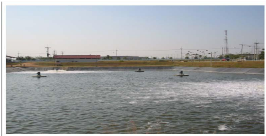
ภาพที่ 8 ระบบบำบัดน้ำเสียของนิคมอุตสาหกรรมอีสเทิร์น ซีบอร์ด ระยอง
