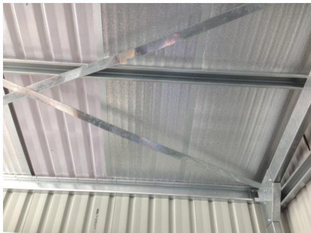
ภาพที่ 4-12 การเชื่อมต่อระหว่างผนังและเพดาน (บริษัท มากทรัพย์ คอนสตรัคชั่น แอนด์ ซัพพลาย จำกัด, 2556)
