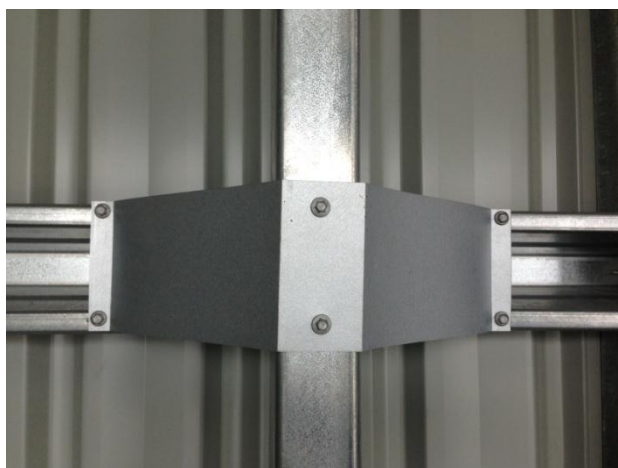
ภาพที่ 4-9 การเชื่อมต่อค้ำยันด้านแรงลม (บริษัท มากทรัพย์ คอนสตรัคชั่น แอนด์ ซัพพลาย จำกัด, 2556)
