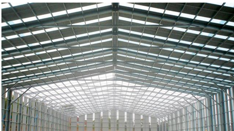
ภาพที่ 4-7 ภาพภายในอาคารระหว่างการติดตั้ง (บริษัท แรนบิวด์ ออสเตรเลีย จำกัด, 2556)
