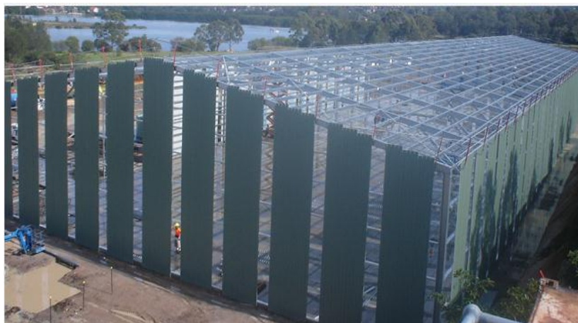
ภาพที่ 4-8 ภาพภายนอกอาคารระหว่างการติดตั้ง (บริษัท แรนบิวค ออสเตรเลีย จำกัด, 2556)
