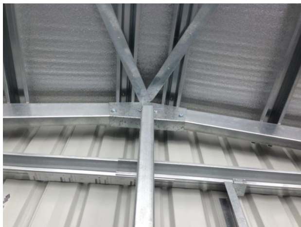
ภาพที่ 4-11 การเชื่อมต่อของฟูกยอดแหลม (บริษัท มากทรัพย์ คอนสตรัคชั่น แอนด์ ซัพพลาย จำกัด, 2556)
