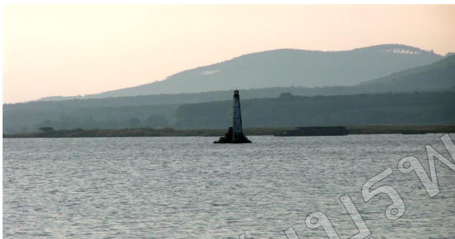
ภาพที่ 6-4 ขอดเมรุวัดกลาง “อ่างเก็บน้ำกระทุง”
