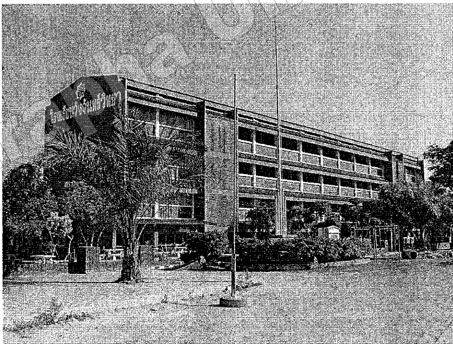
ภาพที่ 30 จุดตรวจวัดระดับเสียงจุดที่ 14
