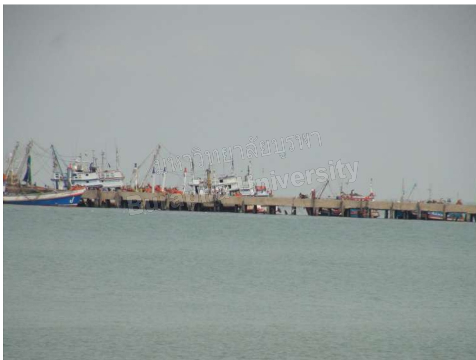
ภาพที่ 45 ท่าเทียบเรืออ่างศิลา (สะพานปลาอ่างศิลา)
