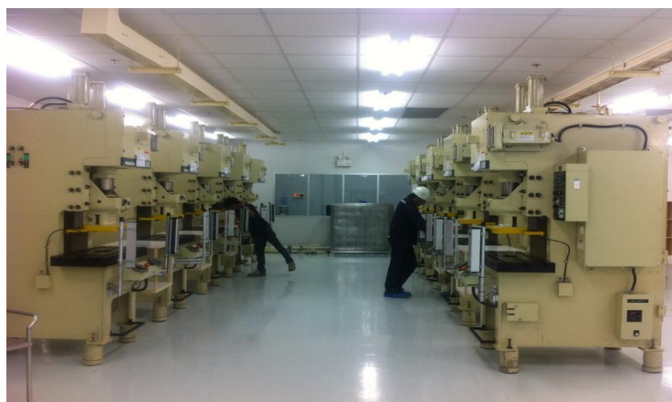
ภาพที่ 2-4 Installation งานติดตั้งเครื่องจักร
