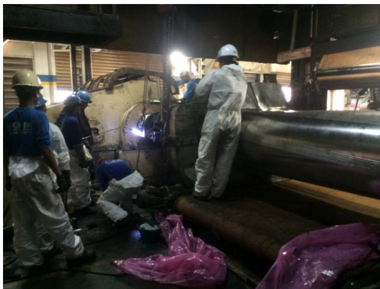
ภาพที่ 2-1 Maintenance work งานซ่อมบำรุง
