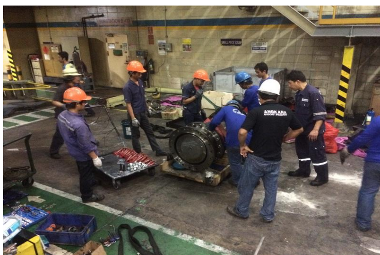
ภาพที่ 2-2 Maintenance work งานซ่อมบำรุง
